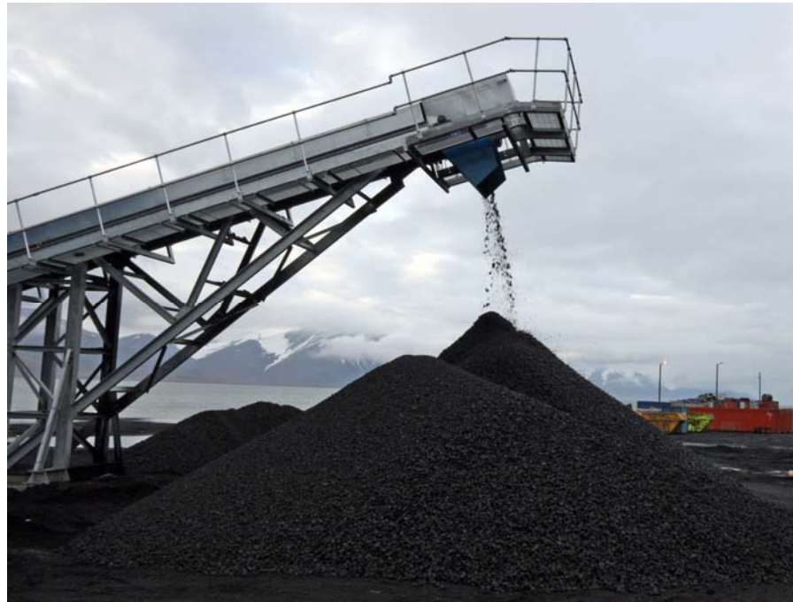
Det lille oppredningsverket på Kapp har en kapasitet på 100 tonn i timen.
