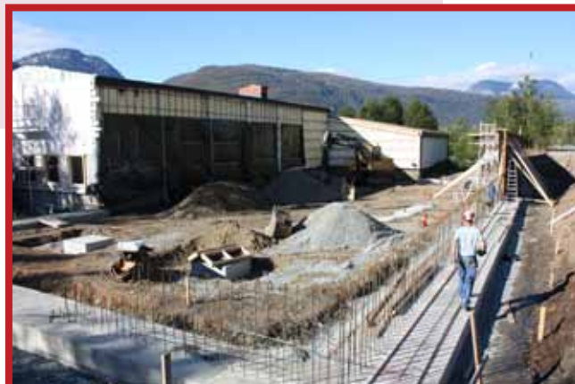
Fundamentet på flerbrukshallen
