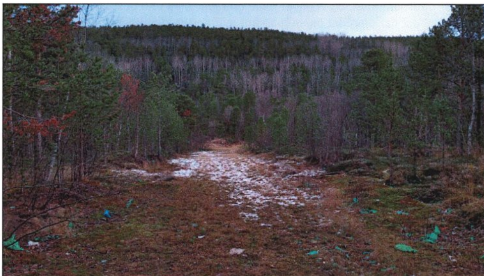
Figur 15: «Veg» fra dagens anlegg inn i tiltaksområdet. Noe plastforsøpling i forgrunnen
