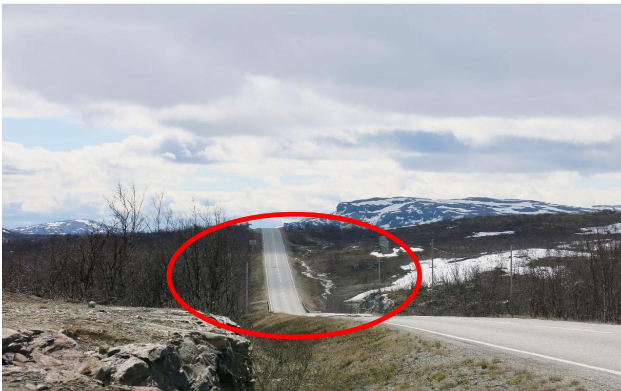
Figur 16: Uheldig kurvatur på veg som blir fylt opp.
