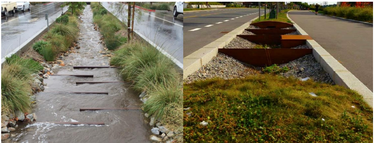
FIGUR 28. Eksempel på blågrønn fordrøyning og infiltrasjon mellom kjørebane og fortau på Ensjo Foto: VAV Oslo kommune.
