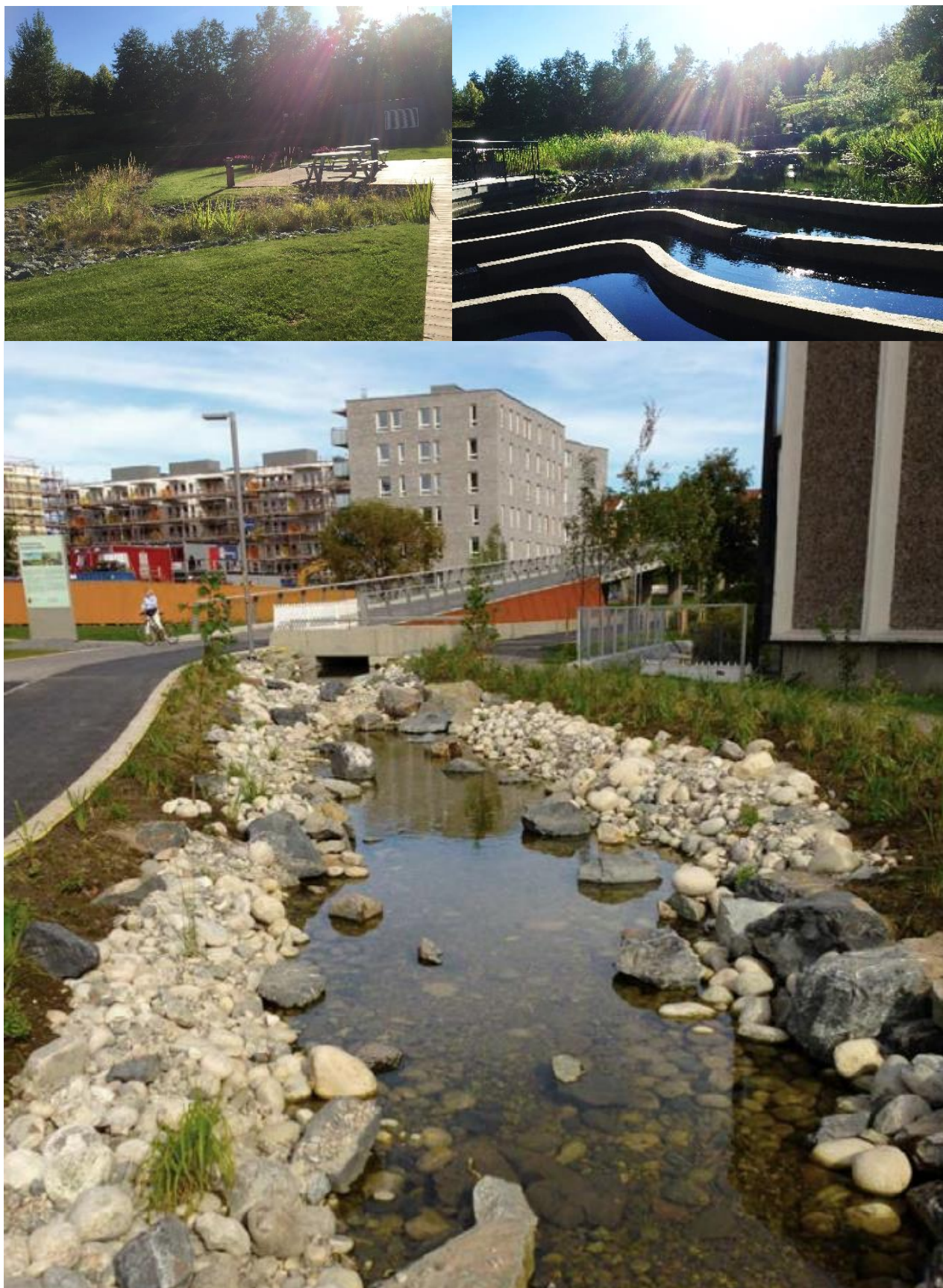
FIGUR 29. Eksempel på gjenåpnet bekkeløp som en del av overvannshåndteringen, Hovinbekken i Oslo.
