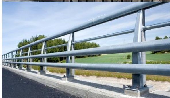
FIGUR 77. Der bilvei går på bro anbefales Sikura brurekkverk fra Ørsta stål leveres varmforsinket, og kan i tillegg lakkere i ønsket RAL-farge i henhold til fargepaletten. Foto: vikorsta.no
