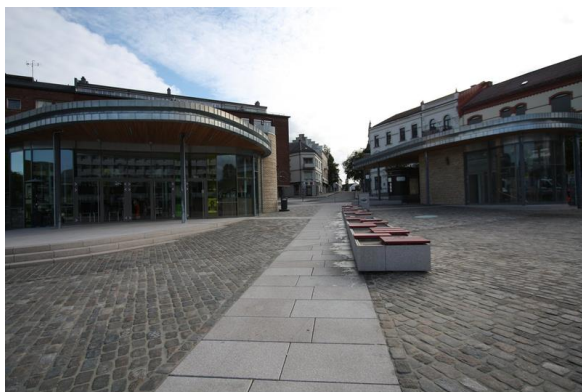
Fig.F16 Kombinasjon av granittheller og storgatestein. Foto:Jogra
