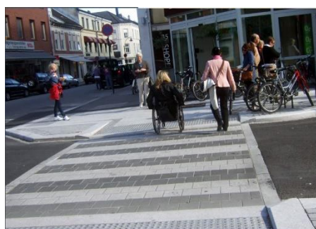
Fig.F07 Fotgjengerovergang i granittstein. Foto: Statens Vegvesen
