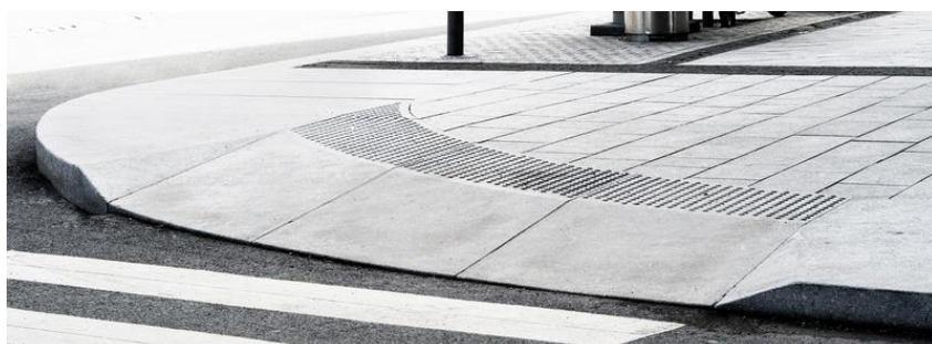
Fig. F18 og F19 Oppmerksomhetsfelt integrert i granittheller. Foto: Jogra
