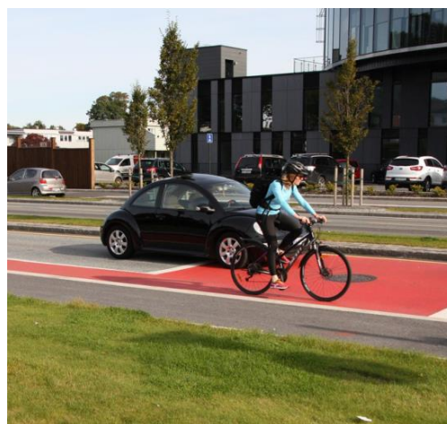
Fig.F06 Rødt dekke benyttes på sykkelveier. Foto: StoCretec Flooring AS
