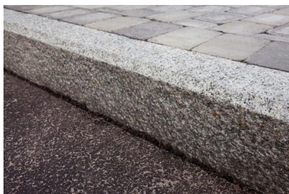
Fig.F08 Lys grå faskantstein/smal kantstein benyttes mellom vei og fortau og sykkelfelt /beplanting. Smal kantstein med radius benyttes i buede linjer. Foto: Beer Sten
