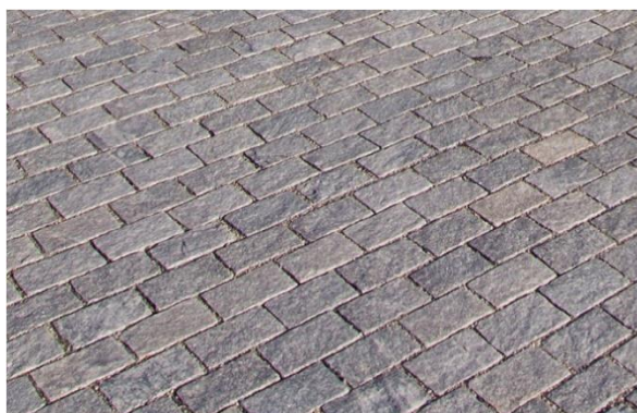
Fig.F13 Storgatestein på fortausareal og i kjørebane. Flammet overflate tilfredsstiller krav om universell utforming. Foto: Beer Sten
