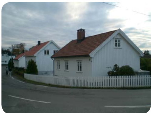
Kolåsveien 12-8 og Storgata 10 (NIKU 2013)
