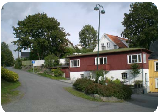
Bolig/lager i Bruerveien 1 (NIKU 2013)
