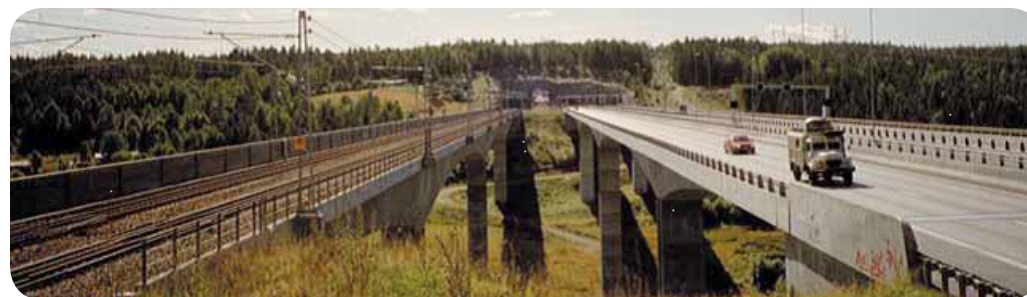
E6 og jernbanebrua over Hølen (Vegvesenet 2009)
