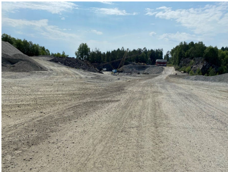
Figur 7: Foto tatt inne i uttaksområdet mot sør, viser vekt og verksted som står ved innkjøringen til området fra Garderveien. Det er arealene på hver side av adkomstveien som ønskes innlemmet i planen. Områdene består i dag av skog. (Feste NØ).
