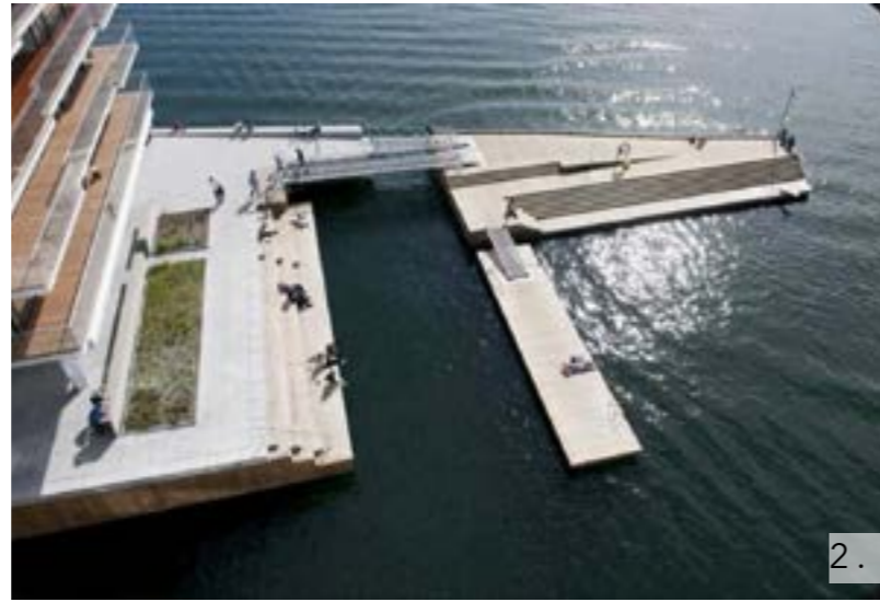
SOLTRAPP NEDTRAPPING MOT VANNET
