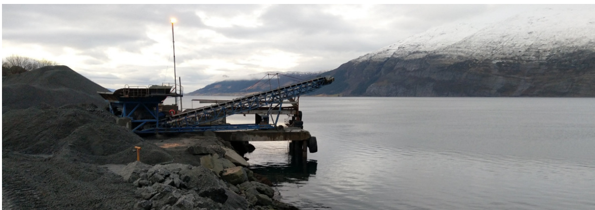
Figur 8. Utskipingskai ved steinbruddet
