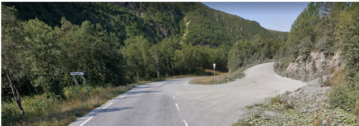
Figur 6. Dagens avkjørsel fra fv808 og inn til steinbruddet.
