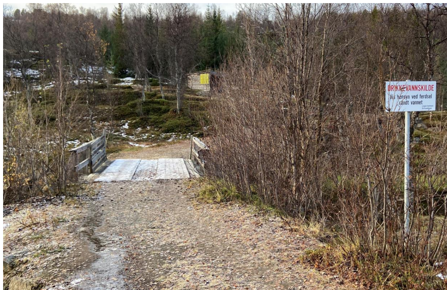
Figur 14 Traktorbru ovenfor dam Elvejordsvatnet
