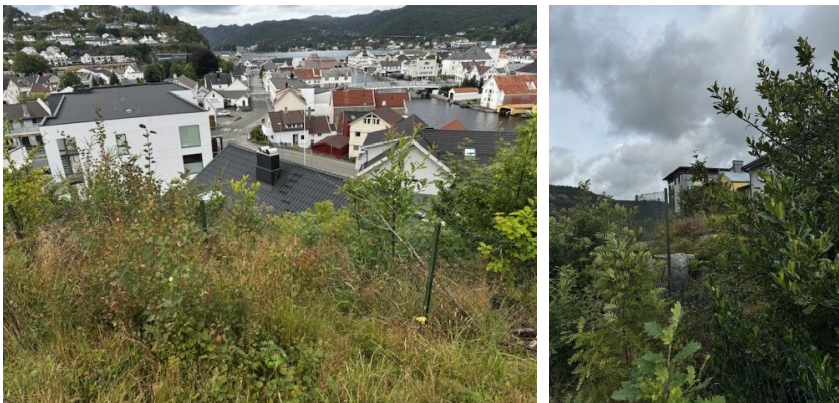
Foto som viser eksisterende, delvis overgrodd fallsikring
