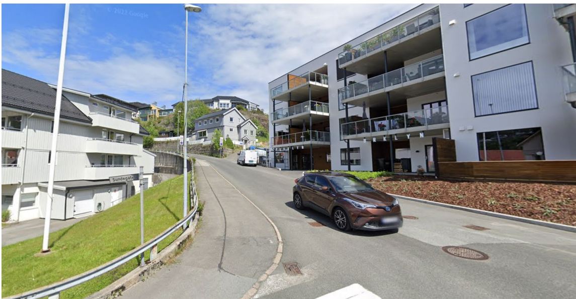
Figur 5.3-2: Eksisterende bolighus ses mellom nyere blokkbebyggelse til høyre, sykehuset over, og Sundeheimen sykehjem til venstre. Omkringliggende bebyggelse er relativt høyreist.
